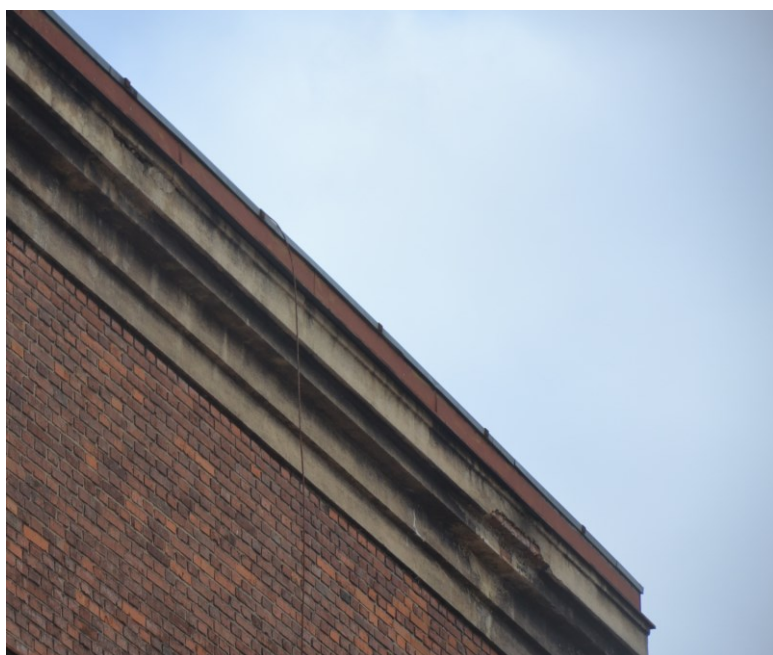
Obr 4 – 6. Příklady poruch střešní římsy.
